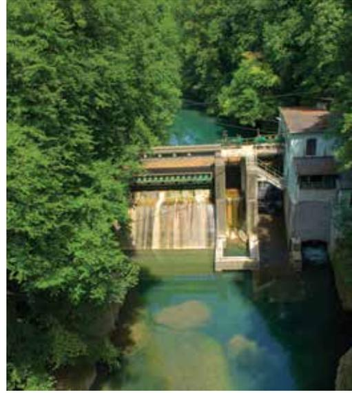
تعمل تركيبات الطاقة الكهرومائية الصغيرة دون الحاجة لسد (الشكل 3.1.9). يتم بناؤها على أنهار صغيرة أو حتى على جداول المياه وتخزن الطاقة في بطارية. ورغم أن طاقتها محدودة إلا أنها كافية لتلبية احتياجات مزرعة صغيرة أو خدمات أساسية في محمية للحياة البرية تقع بالقرب من النهر.
