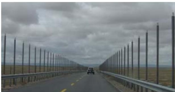
**Fig. 2.8.14.** Route reposant sur des supports enfoncés profondément dans le sol.
